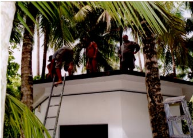
Nous trouvons un abri provisoire sur le toit
